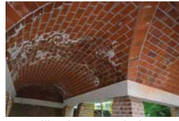
17 Pasillo de Artes Plásticas mal restaurado
