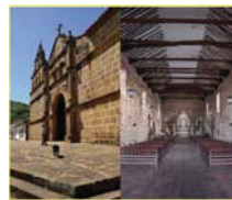
24 Iglesia de santa Lucia fachada e interior
