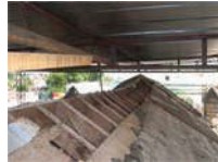
2 Desmonte parcial de la cubierta con la viga cumbreira fracturada en el medio
