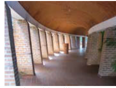
18 Grietas del Pasillo
