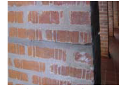
20 Grieta en un contrafuerte
