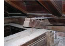
4 Consolidación de emergencia ente tirantes pareados y canes (1869)
