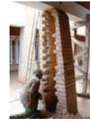
19 Ejemplo de consolidación agresiva del contrafuerte
