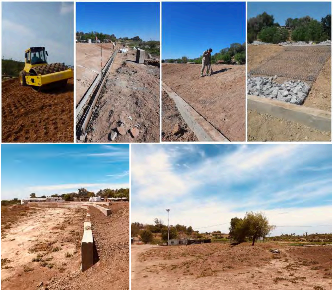
Figura 15. Fotografías del avance de obra
