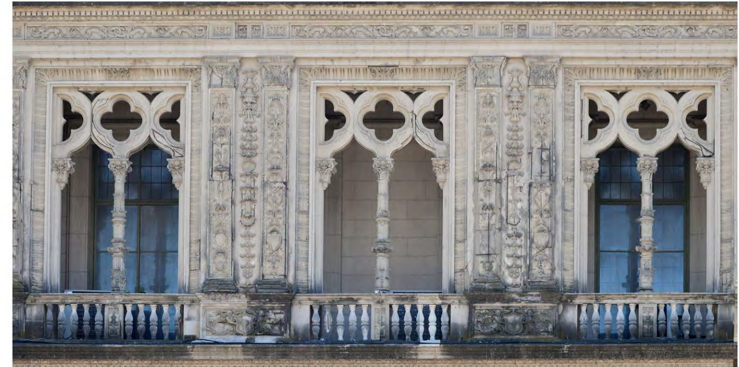
Restauración arcos cuatrifolios, pilastras, balaustradas, fuste de columna, bajo-cornisa: Antes y Después.
