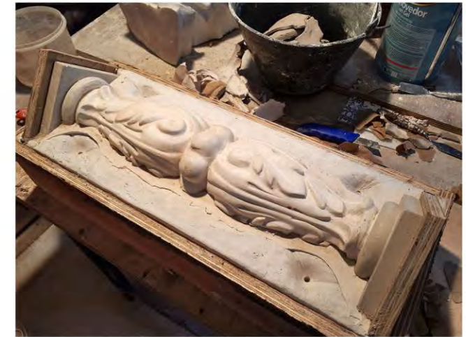
Balaustre: restauración; molde; pieza nueva.
