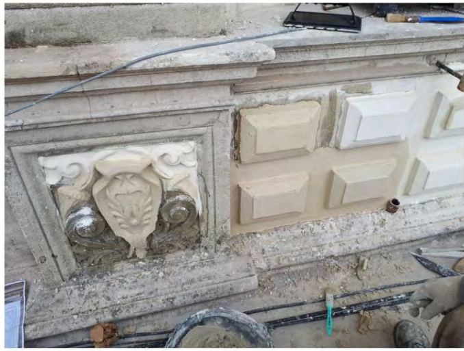
Restauración de enlucidos (revoques)
