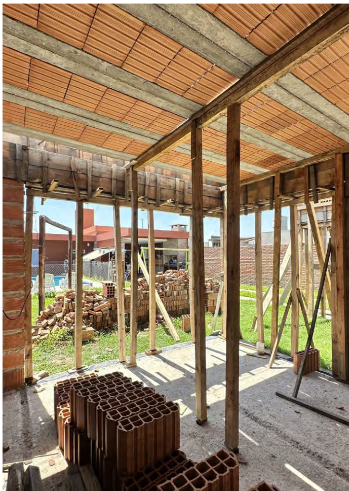
CASA EN VOLADIZOS - Imágenes de obra.
