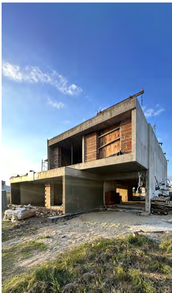
VIVIENDA S-B - Imágenes de obra.
