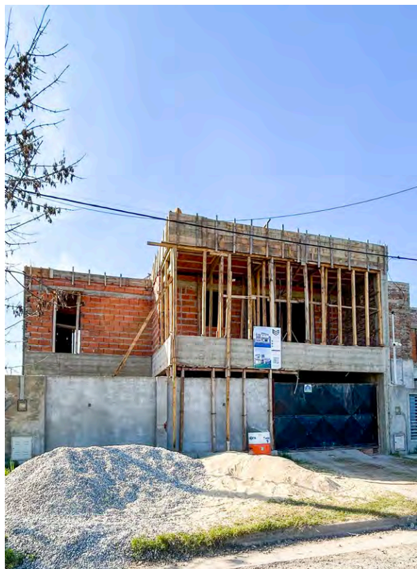
CASA EN VOLADIZOS - Imágenes de obra.
