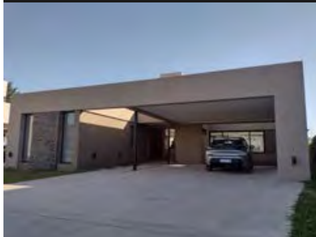
FACHADA NORTE *Buscar la apertura hacia las mejores condiciones climaticas *Generar filtro de privacidad de la calle
