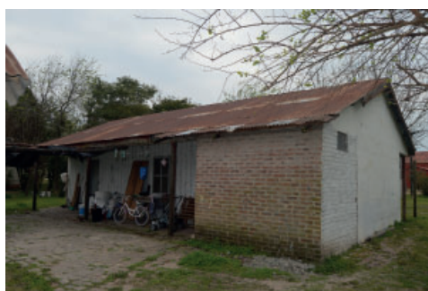
Figura 15c. Ampliación de vivienda construida con entramado de madera. Cerramiento parcial de galería con mampostería de ladrillos macizos
