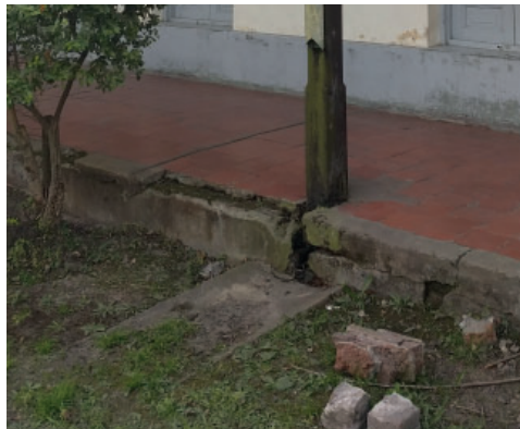
Figura 14. Ejemplos de componentes de los sistemas de desagüe pluvial, encontrados en diferentes edificios y localidades. Se presenta como albañal abierto que permite alejar el agua de la descarga pluvial de las columnas en galerías.
