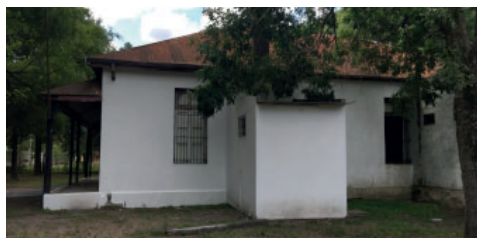
Figura 15a. Ampliación de vivienda de muros de ladrillos. Por lo general se adosa un núcleo de baños a las viviendas, ya que en las estructuras originales, este espacio de servicio sanitario se encontraba alejado de la residencia, al igual que el espacio cocina.
