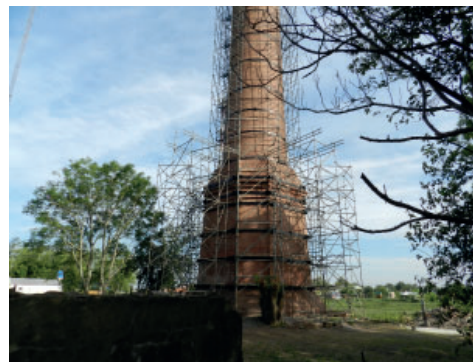
Figura 1. Restauración de la chimenea de Villa Ana. Fotografía de la base.
