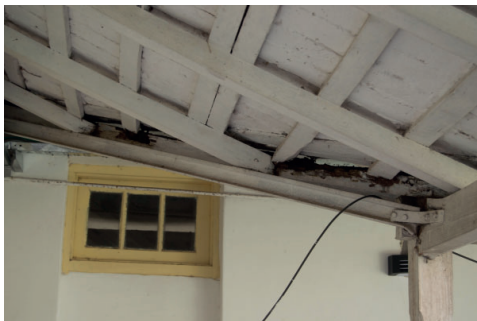
Figura 9b. Refuerzo con perfil C de acero y alas desiguales, tipo riel, bajo estructural de madera en galería del hospital de Tartagal.
