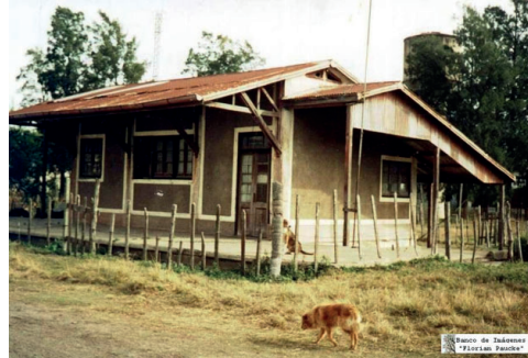
Figura 10a. Estación ferroviaria “La Gallareta” (1998), Fuente: Banco de imágenes Florián Paucke https://www.santafe.gov.ar/florianpaucke
