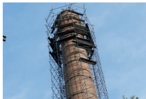
Figura 2. Restauración de la chimenea de Villa Ana. Fotografía del coronamiento.
