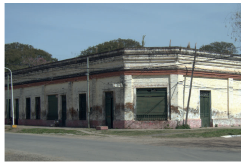
Figura 11b. Estado actual Almacén de la Gallareta (2019)
