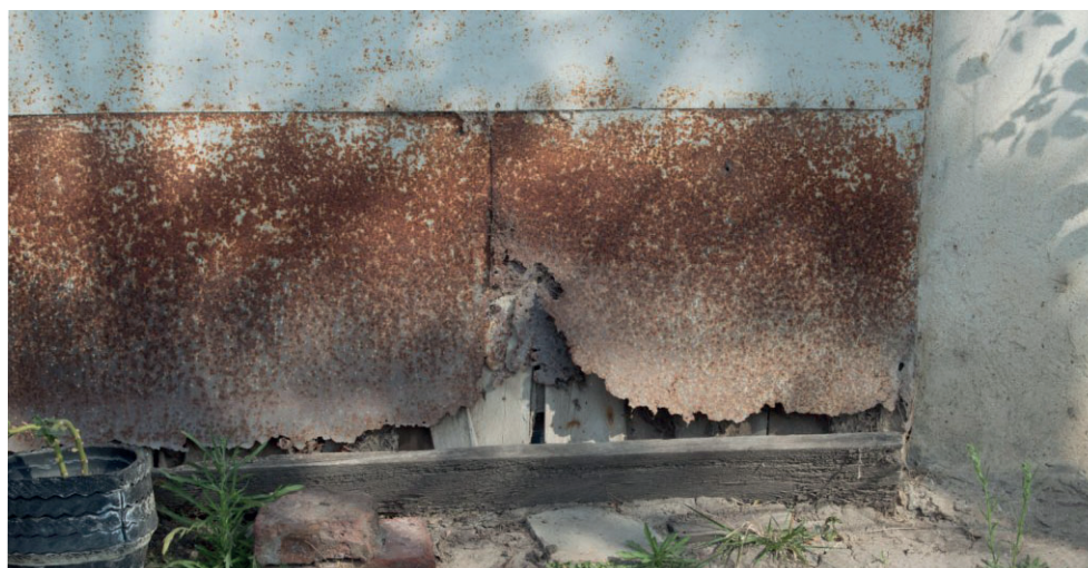
Figura 3. Entramado de madera y revestimiento de láminas lisas de acero como cerramiento y terminación. Casa para obreros, La Gallareta.
