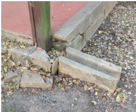
Figura 14. Ejemplos de componentes de los sistemas de desagüe pluvial, encontrados en diferentes edificios y localidades. Se presenta como albañal abierto que permite alejar el agua de la descarga pluvial de las columnas en galerías.
