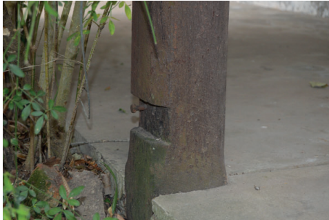
Figura 9a. Columna de quebracho, actual centro de genética, estancia Las Gamas.
