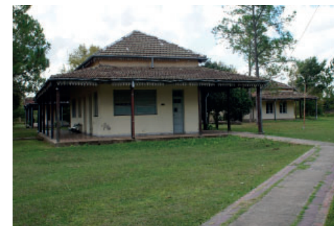
Figura 13. Hospital de Villa Guillermina.
