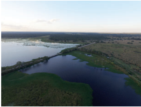
Figura 4. Yugo quebrado (Villa Guillermina)
