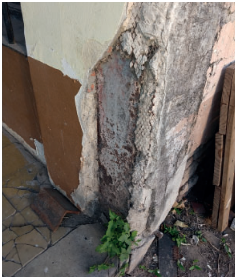
Figura 5b. Detalle de refuerzos metálicos en muros de mampostería, vivienda para obreros, La Gallereta.
