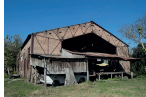
Figura 6a. Estructura utilitaria en las inmediaciones de la fábrica en Villa Guillermina. Edificio con estructura de perfiles y cerramiento de ladrillos asentados en mezcla de cal y arena.
