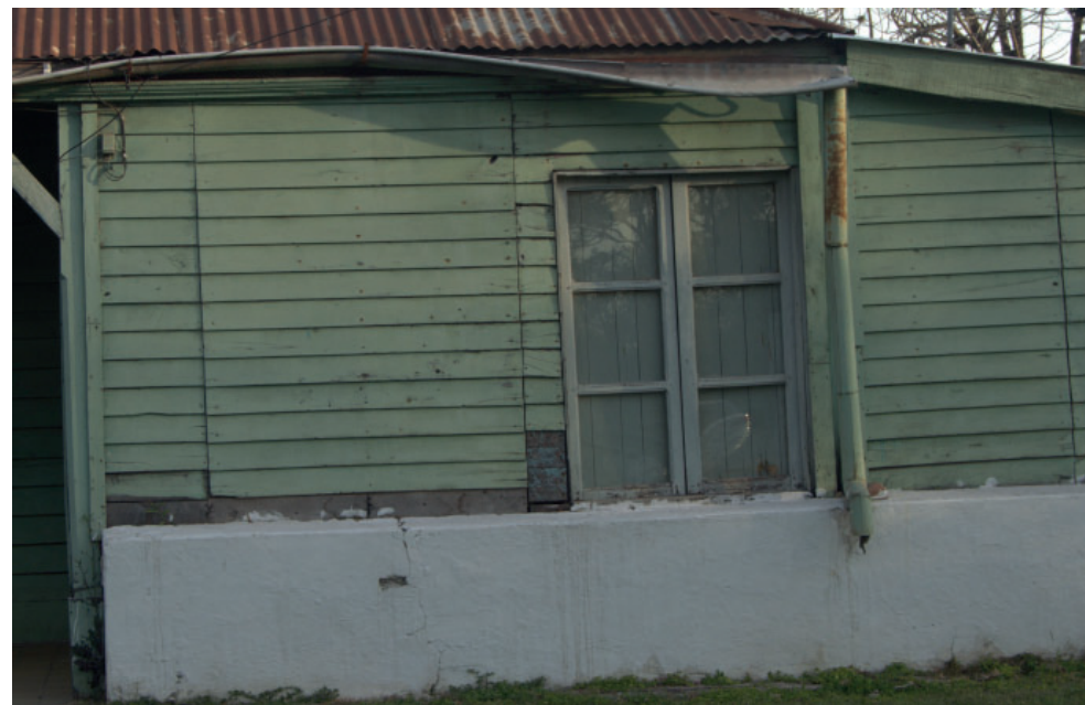
Figura 2. Entramado de madera y tablillas del mismo material. Los muros de cemento son de mampostería tradicional. Club para empleados, Villa Ana.
