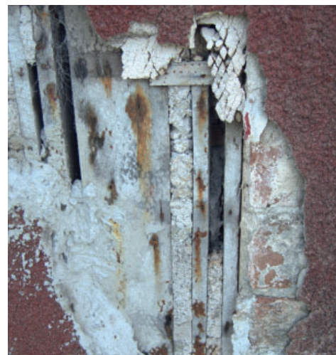
Figura 1a. Entramados de madera revocado con mortero, estación ferroviaria La Gallareta.
