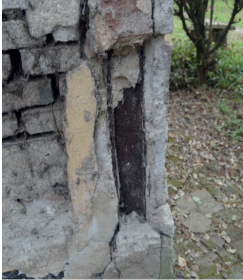
Figura 5a. Detalle de perfil metálico en muros de mampostería, vivienda para obrero, Estancia la Gamás.
