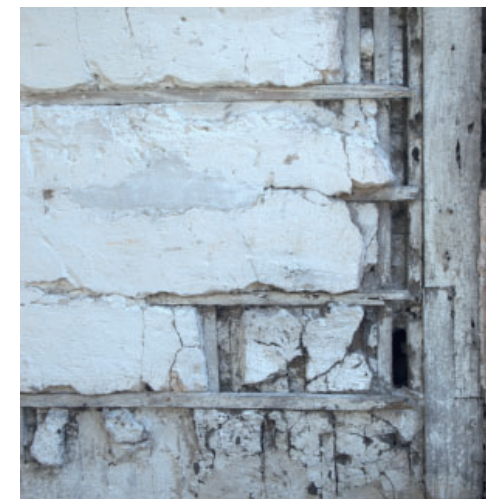
Figura 1b. Entramado de madera revocado con mortero, casa del químico Villa Guillermina.
