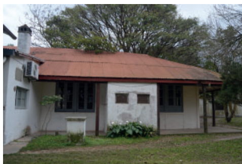
Figura 15b. Ampliación de vivienda mediante el cerramiento parcial de galería.
